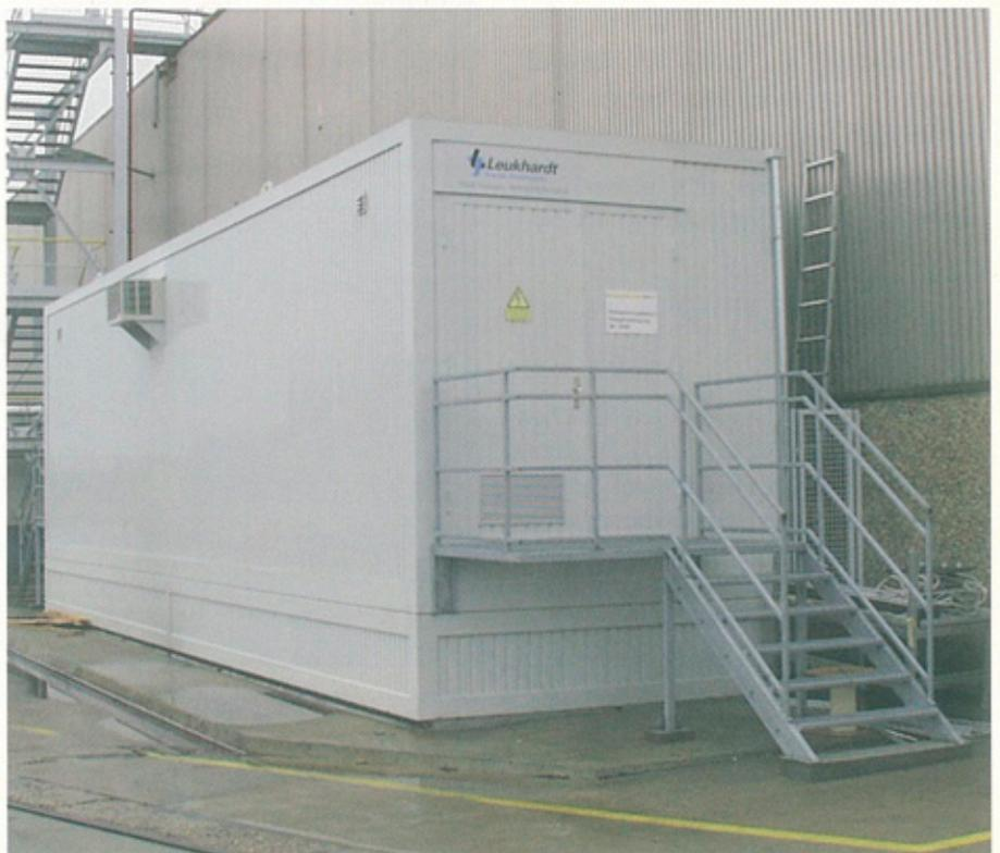
▲ Betriebsbereit sofort nach Ankopplung ans Netz: mobiler Schaltcontainer im Einsatz in einem Automobilwerk
